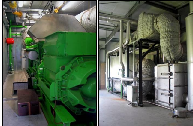
Betrieb Polmann / Wärmeerkraftkoppelungs-Anlage: Der Betrieb betreibt ebenfalls eine Wärmeerkraftkoppelungs-Anlage, von der die Abwärme zur Heizung der Häuser genutzt werden kann. Die Anlage kostete total 3 Mio. € und sollte innerhalb von 10 Jahren amortisiert sein. Die Wartung kostet jährlich 200'000 €.
